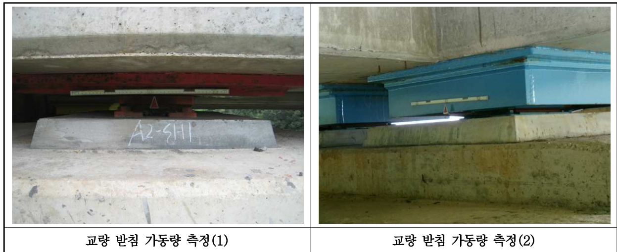
【사진 1.3.15】 교량받침 이동량 측정
