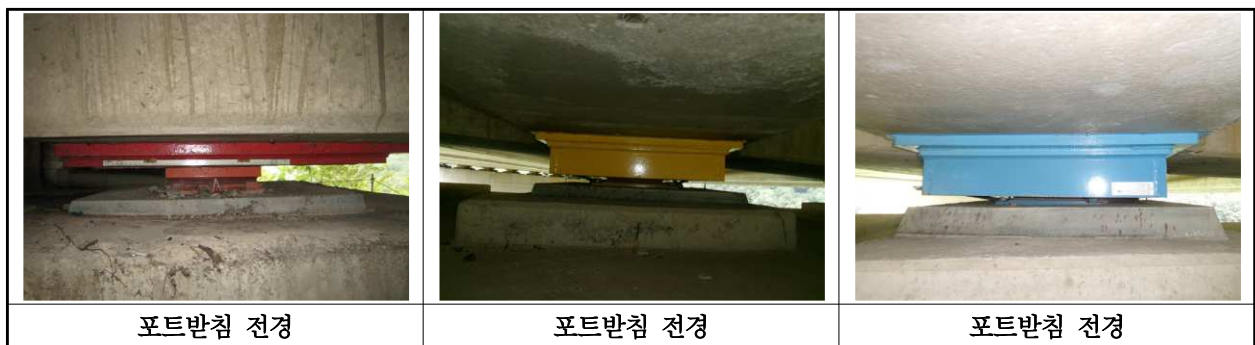
【사진 1.3.37】 교량반침 전경
