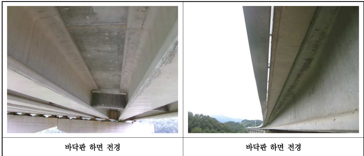
【사진 1.3.27】 바닥판하면 전경
