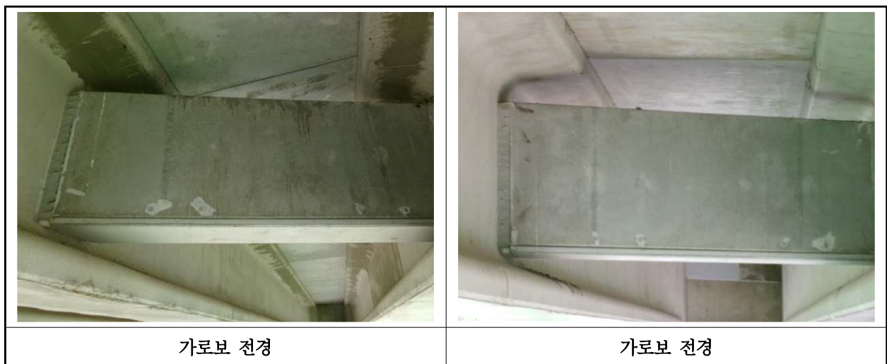
【사진 1.3.6】 가로보 전경
