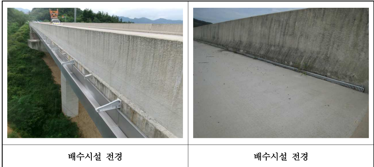
【사진 1.3.46】 배수시설 전경
