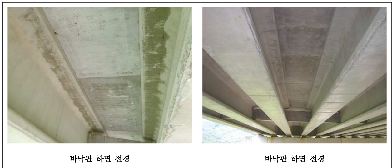
【사진 1.3.2】 바닥판하면 전경
