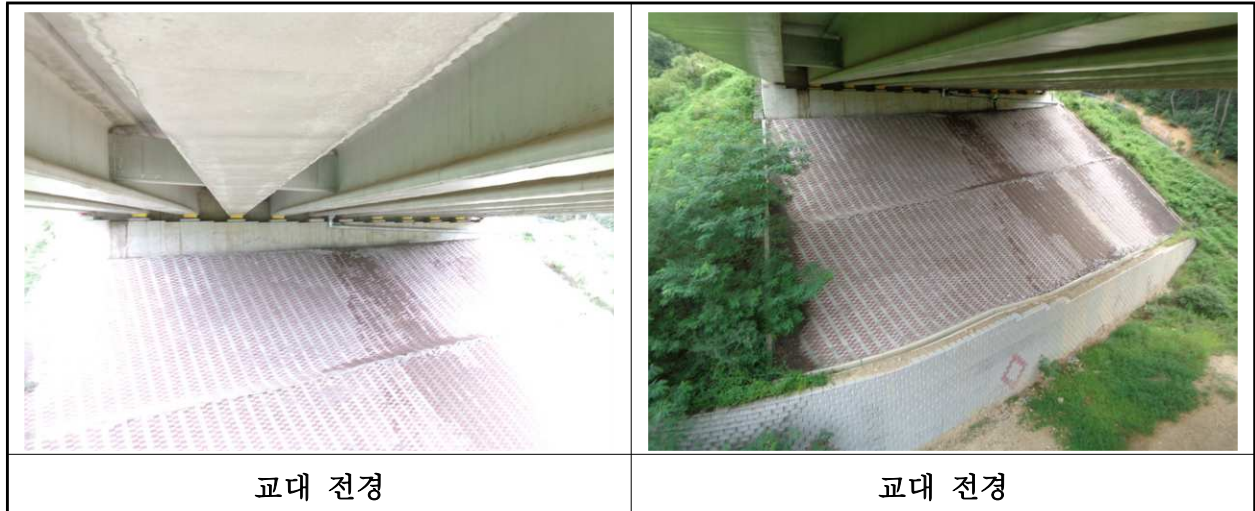
【사진 1.3.8】 교대 전경
