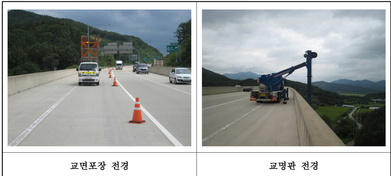
【사진 1.3.19】 교면포장 전경
