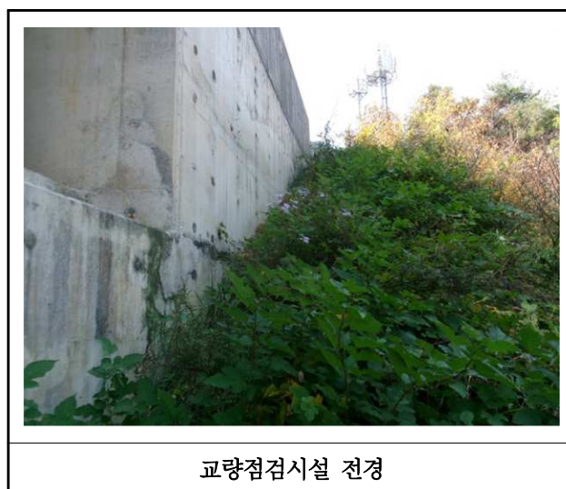
【사진 1.3.25】 교량 점검시설 전경
