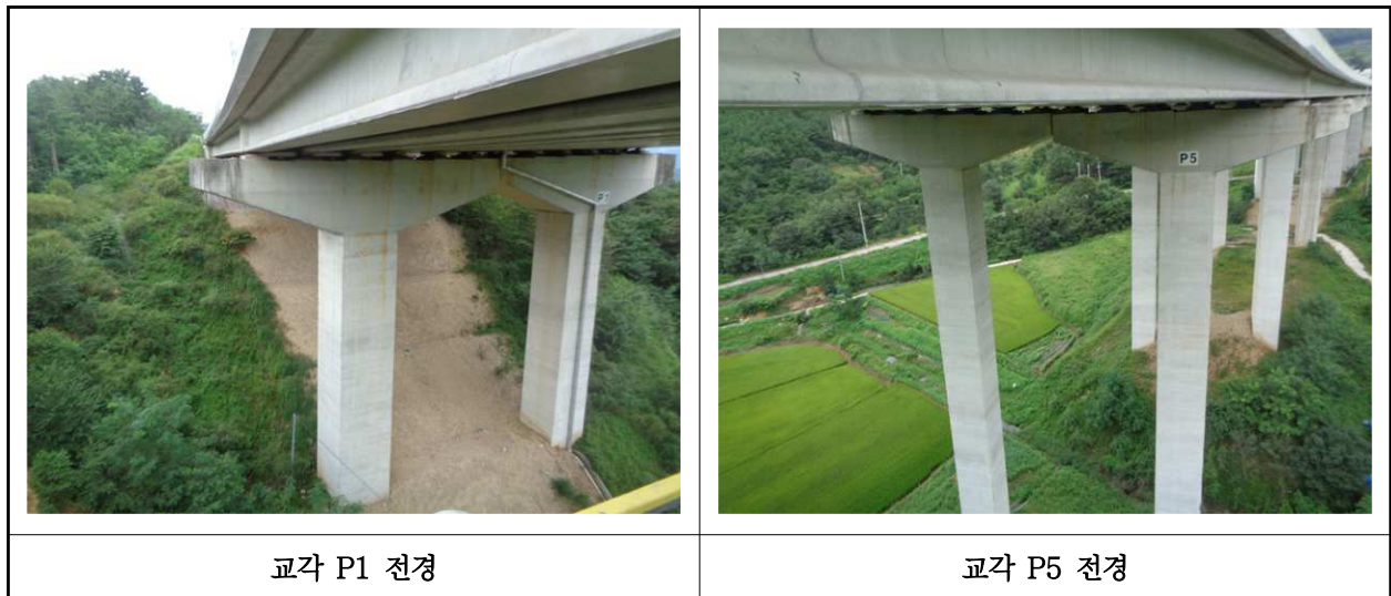
【사진 1.3.35】 교각 전경
