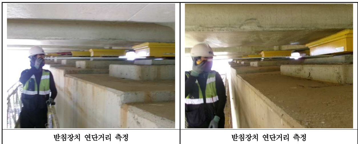
【사진 1.3.39】 교량받침장치 연단거리측정
