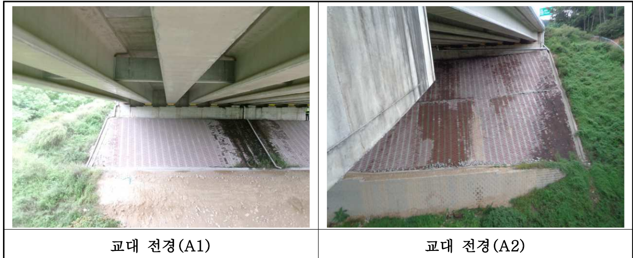
【사진 1.3.33】 교대 전경
