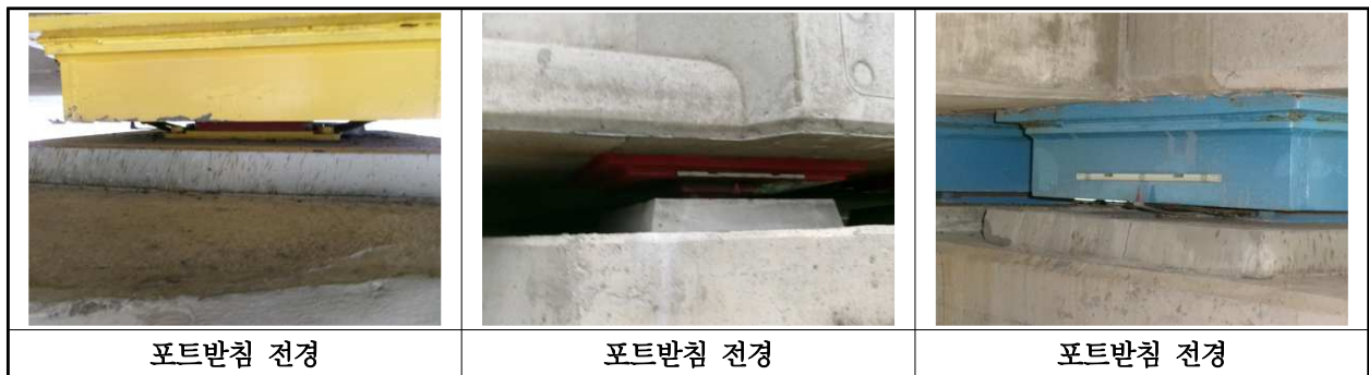
【사진 1.3.12】 교량받침 전경
