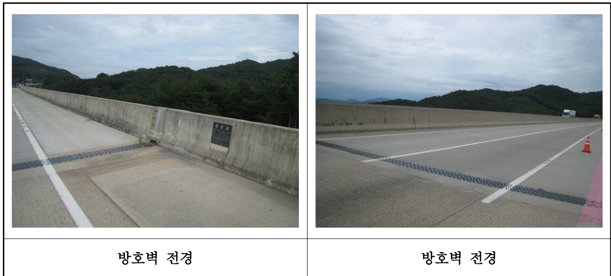
【사진 1.3.48】 방호벽 및 중앙분리대 전경
